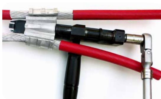
6. Ajustar mediante la llave el tornillo que introduce la cuña elástica
